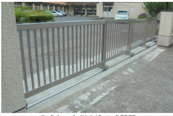
完成なった引き込み式門扉
