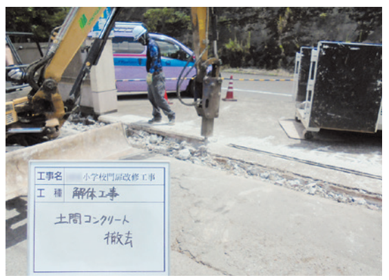
コンクリート撤去作業
