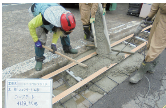
やっとコンクリート打ちができる状況に
