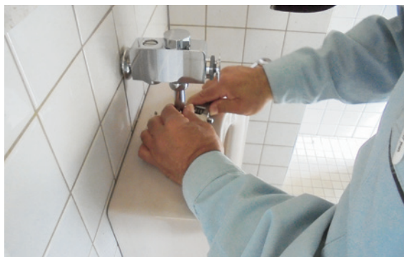
新型バルブとの交換工事
