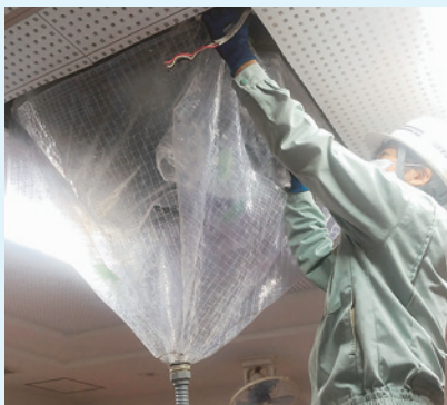
熱交換機（フィン）の洗浄準備
