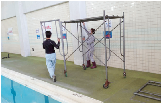
高所作業台の組み立て
