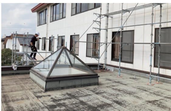
防水工事前の防水シート
