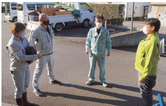
作業前の打ち合わせ
