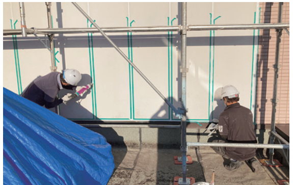
シーリング打ち換え作業
