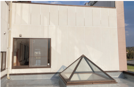
シーリング作業完了
