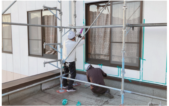
サッシ周りや外壁ジョイントの劣化修理
