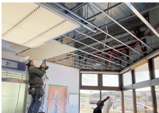
張り替え工事
