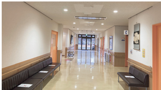
照明交換後の院内
