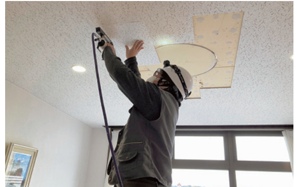
天井板のはり替え作業
