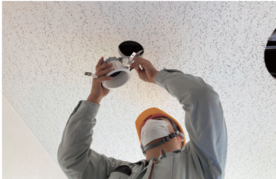
LEDの埋め込み作業
