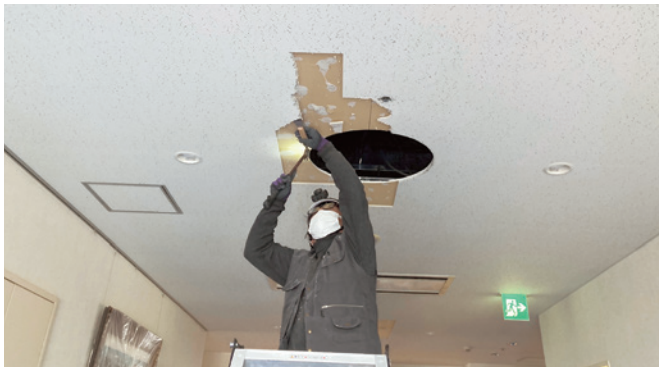
天井板のはぎとり作業
