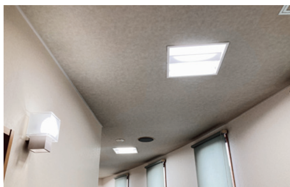
LED照明交換後の中待合室
