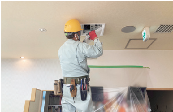
診療室の工事
