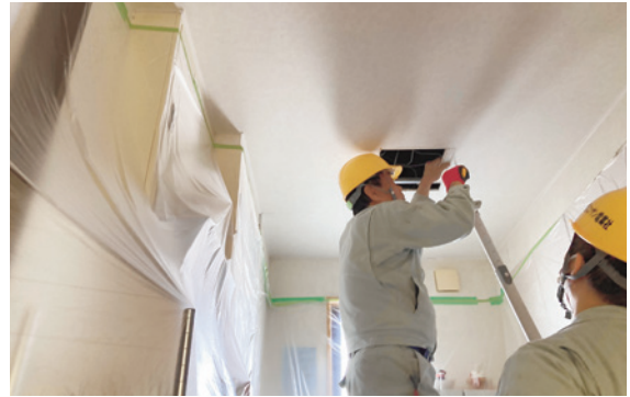
吸塵しながらの工事
