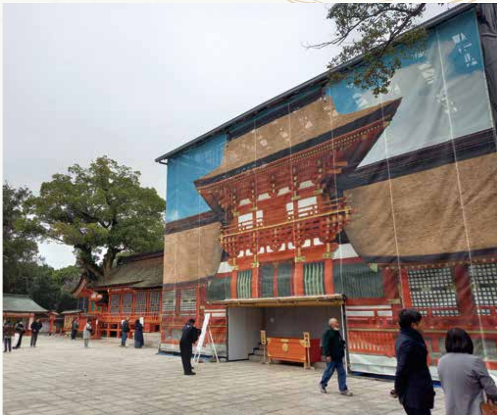
改修中の本殿
