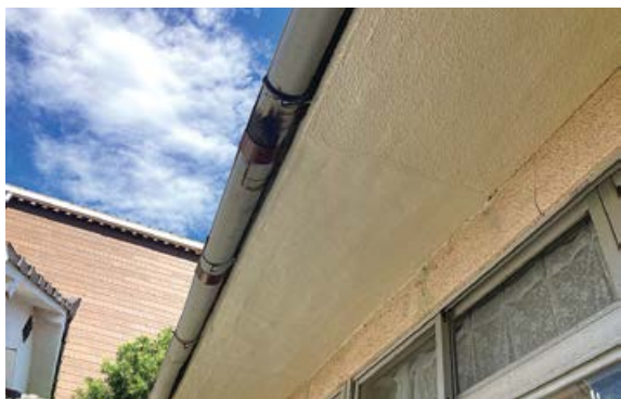
修繕後の軒天
