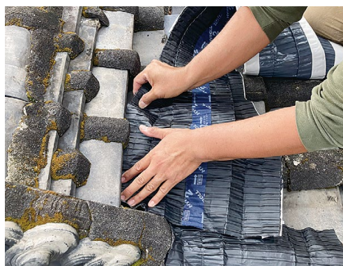
乾式面戸シートハイロール張り
