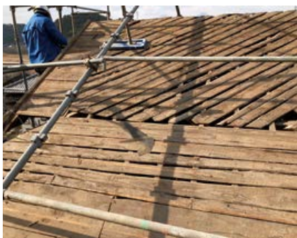
野地板の様子
