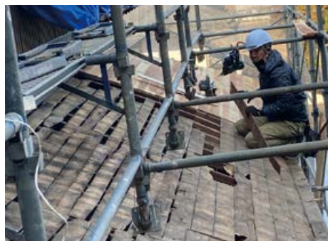
野地板の張り替え
