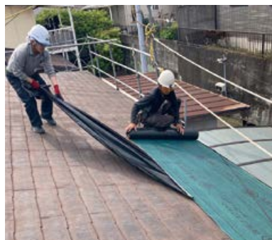
ルーフィング張り
