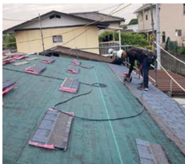
アスファルトシングル張り
