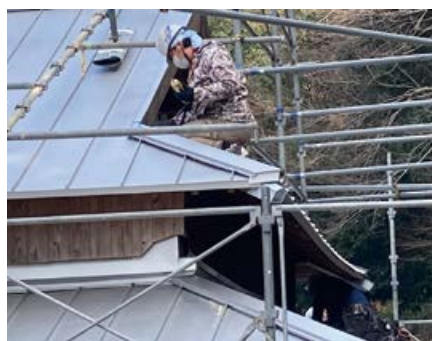
先端部分の張り替え工事
