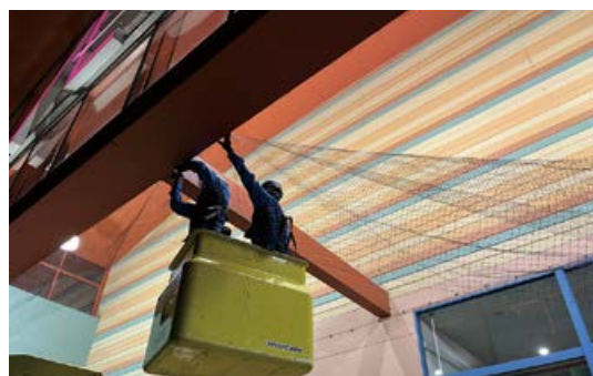
ネットの取り付け
