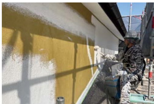
壁面の下塗り
