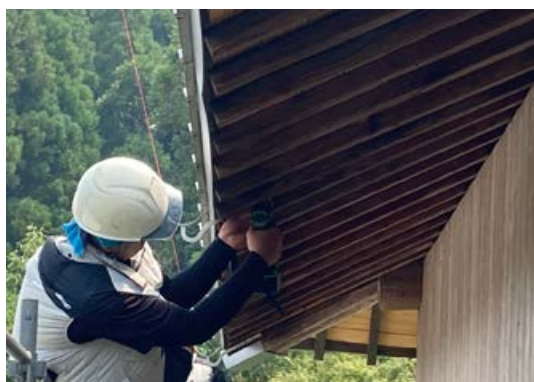
鶴首の取り付け工事
