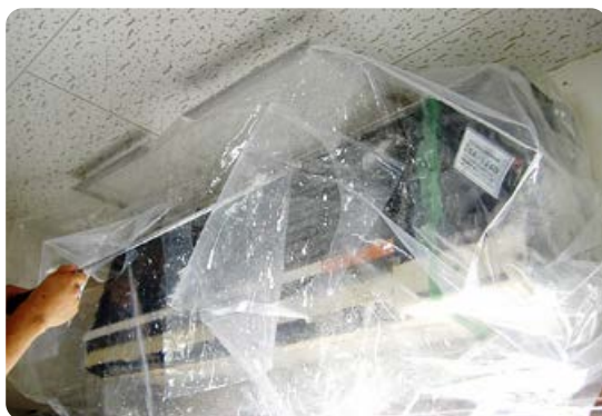
エアコン洗浄
